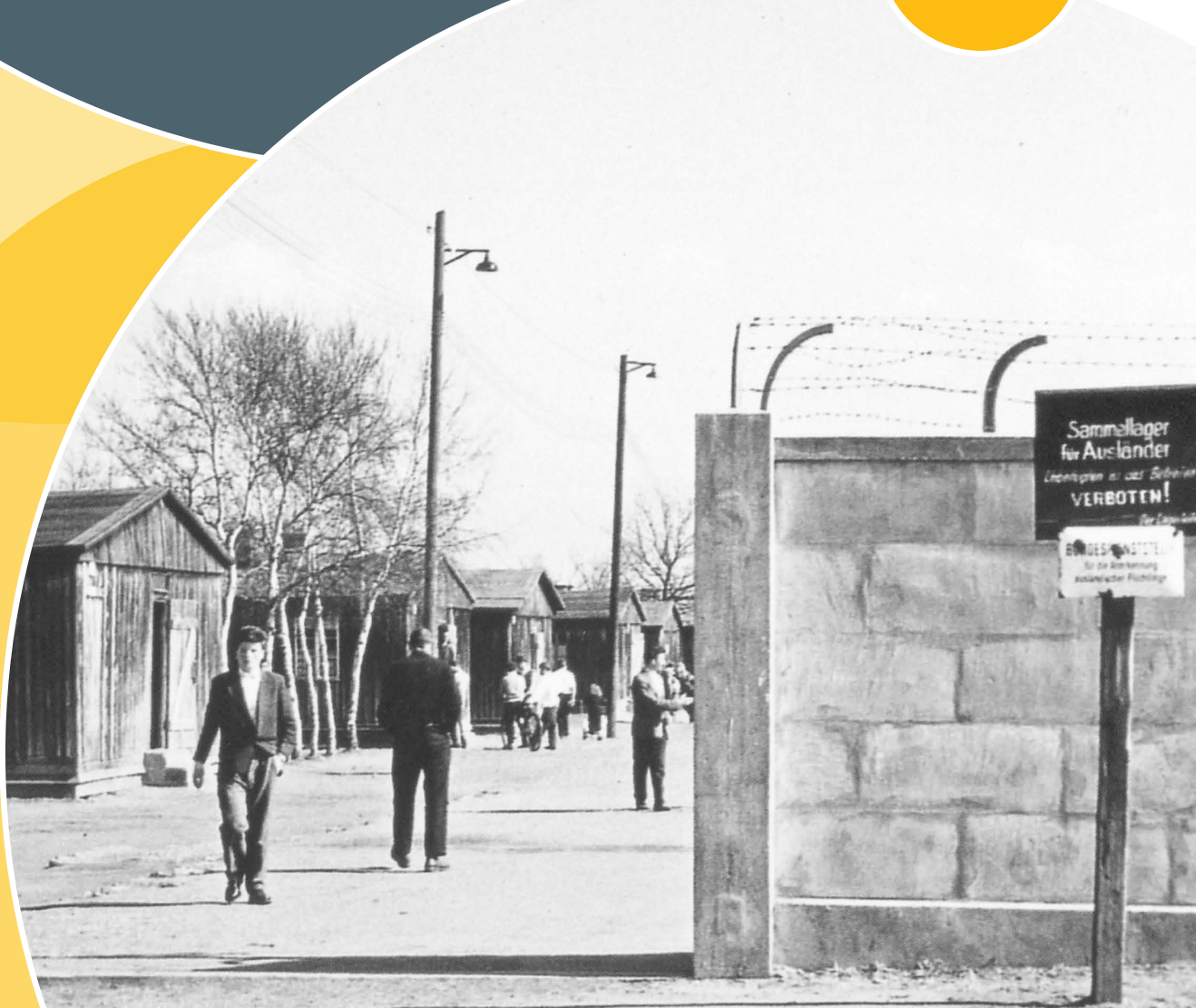
Eine historische Aufnahme des ehemaligen Kriegsgefangenenlagers Langwasser.
